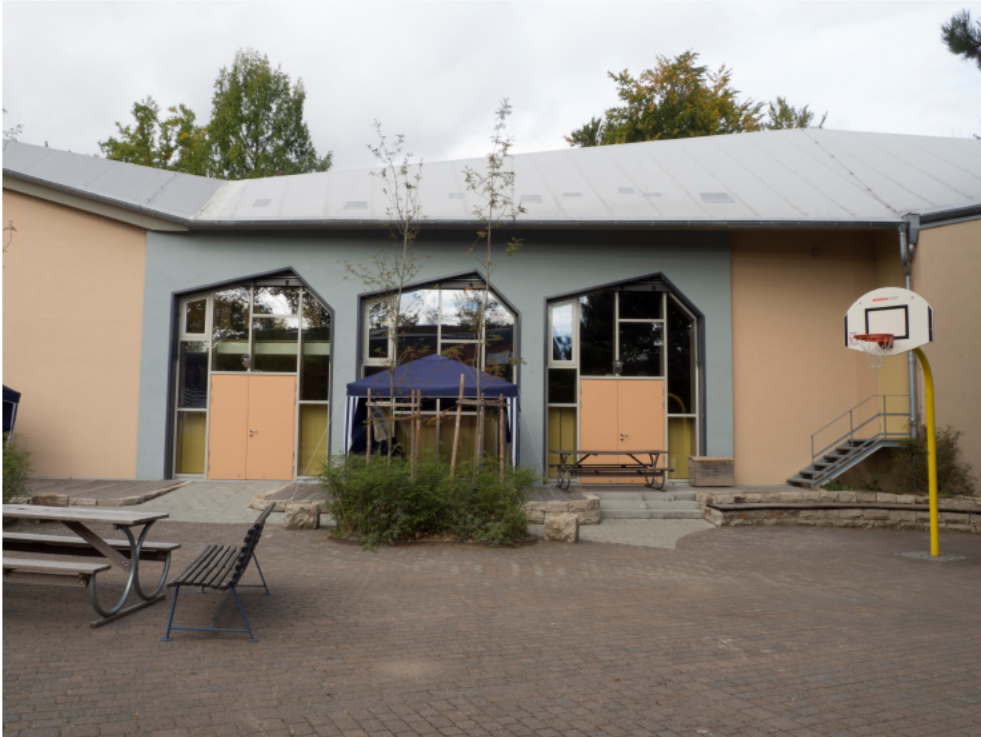
Drei neue Fensterelemente stellen eine visuelle Verbindung zwischen Veranstaltungssaal und Schulhof her. Foto: Eva Rohland
